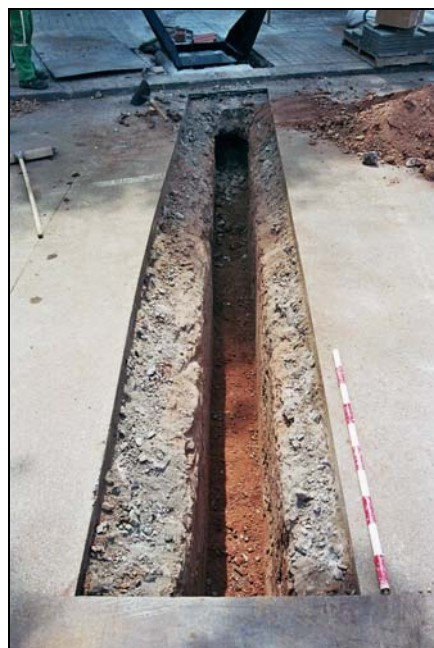
FOT. 4: Vista general d'un tram de la Rasa 2 i Arqueta 2.
