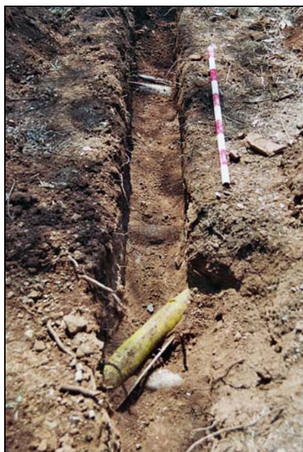
FOT. 3: Cables elèctrics i tubs d'aigua(Rasa 4).
