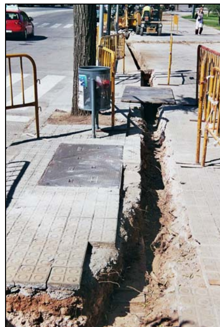
FOT. 2: Vista detallada UE-111.
